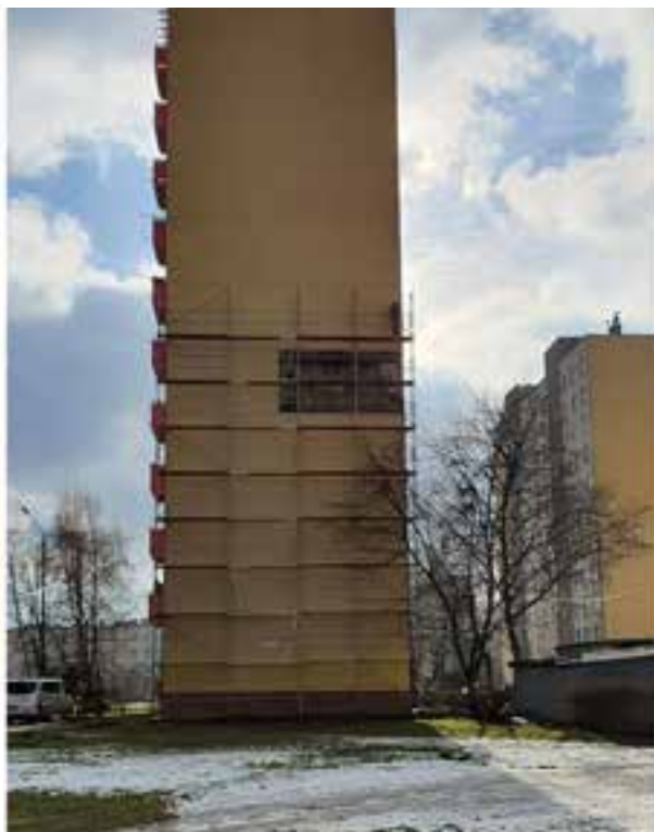
ul. Pomorska 17-21 Ściana szczytowa
