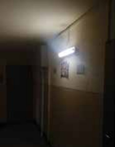
Wymiana oświetlenia na korytarzach klatek schodowych
